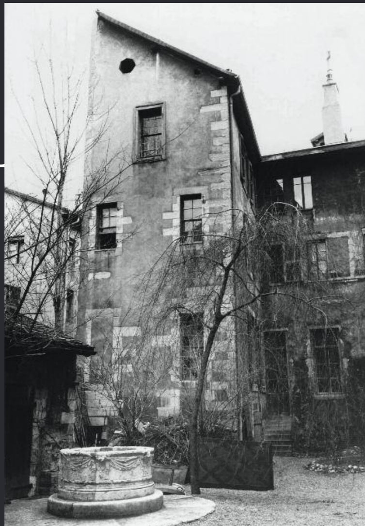
Vue ancienne du jardin avant restauration de la maison
